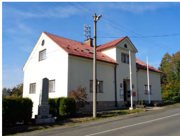
Nová omítka na budově obecního úřadu
