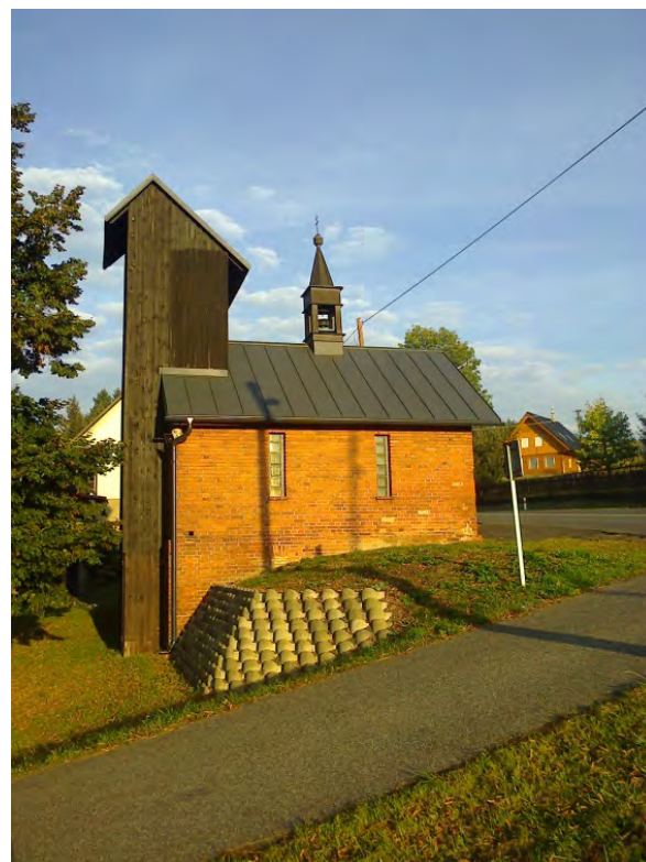
Výměna střešní krytiny na hasičské zbrojnici
