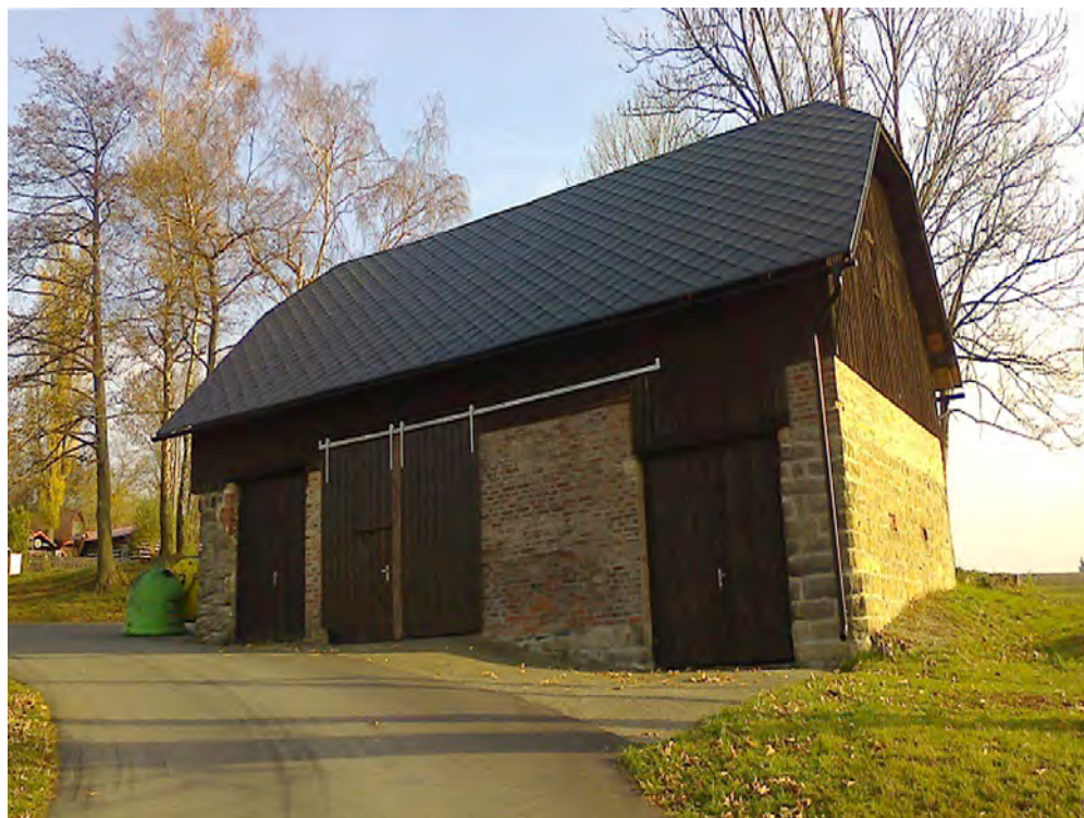
Oprava obecní stodoly
