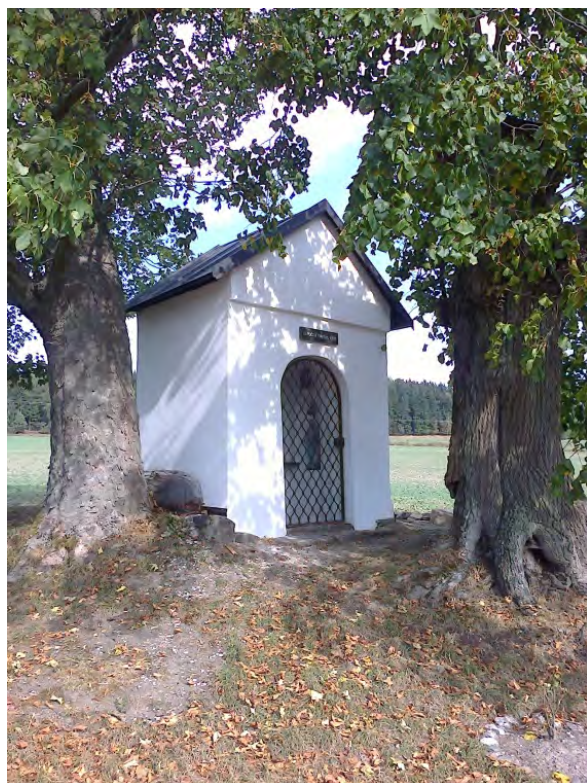
Oprava kapličky SVATÉHO KŘÍŽE
